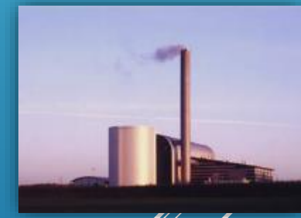
Nhà máy nhiệt điện kết hợp Combined heat & power plants
