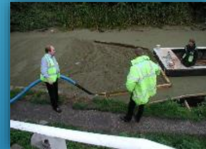
Làm sạch kênh Canal cleaning
