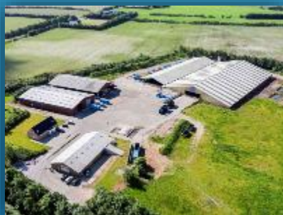
Nhà máy phân trộn sinh học bền vững Sustainable Biocompost Plant
